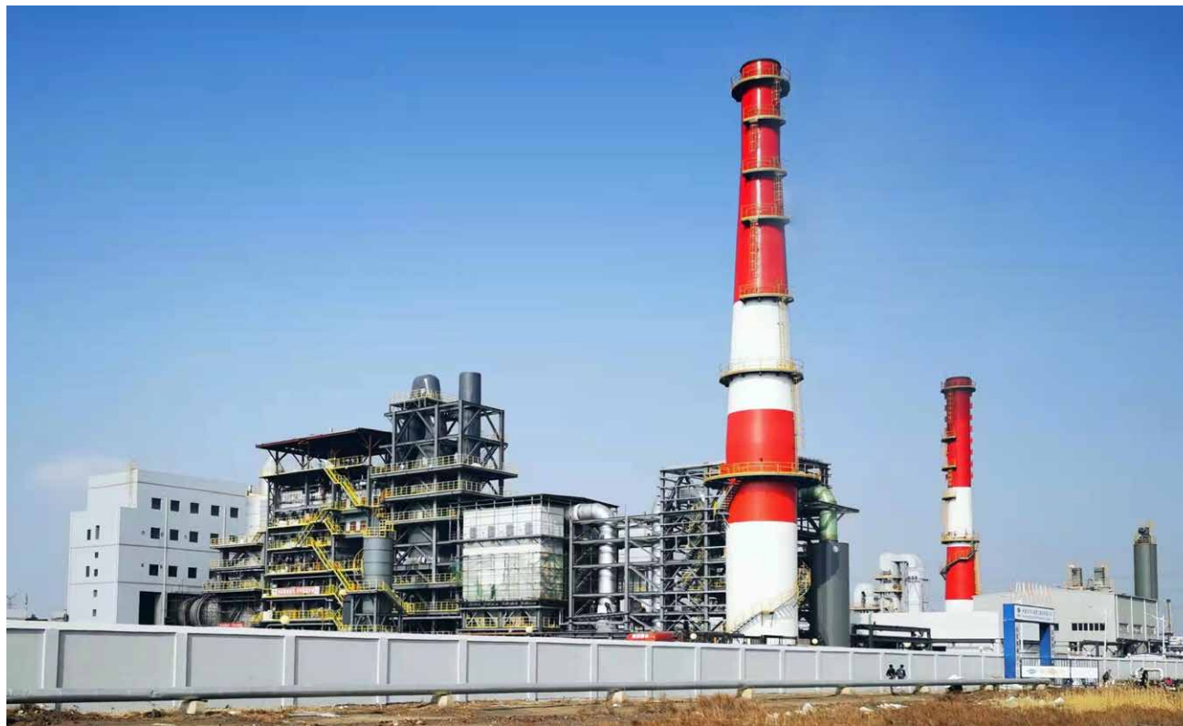
* 威立雅天津危废处置项目
