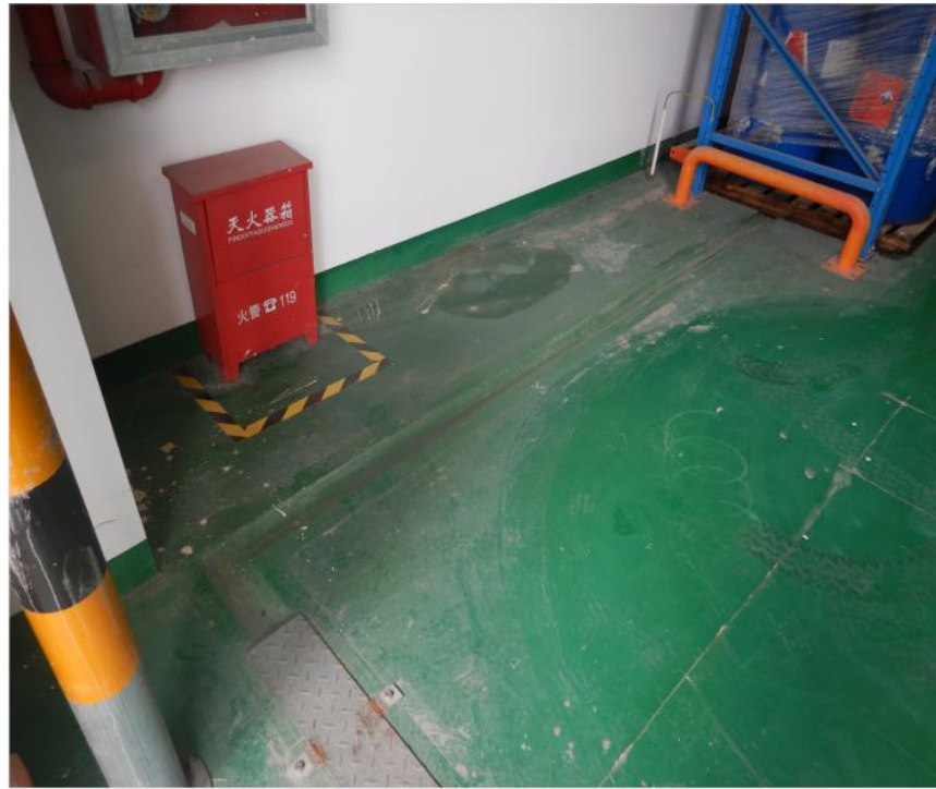
危废暂存库 导流槽
