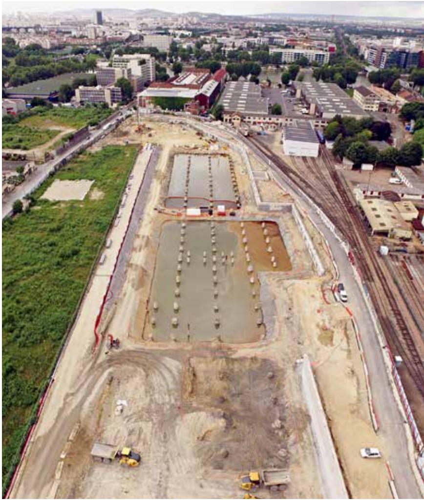
在Saint-Ouen (法国)，GRS Valtech公司对规划用作巴黎地铁14号线车厢维护和调试场地的土地进行了修复。
